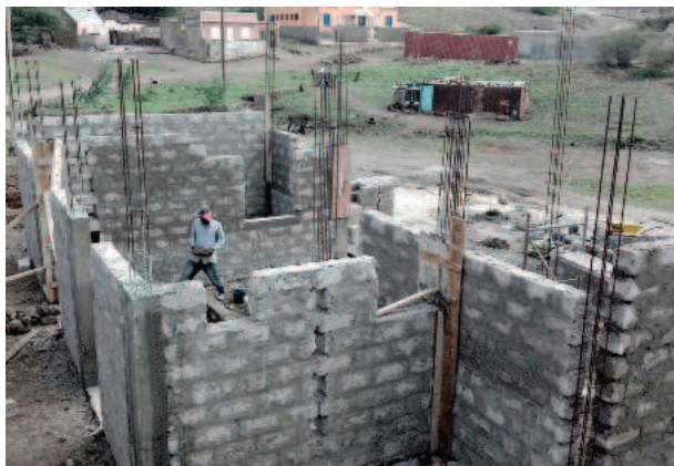
O Centro de Promoção Turística e Transformação Agro - Alimentar de Lameirão na fase inicial das obras
